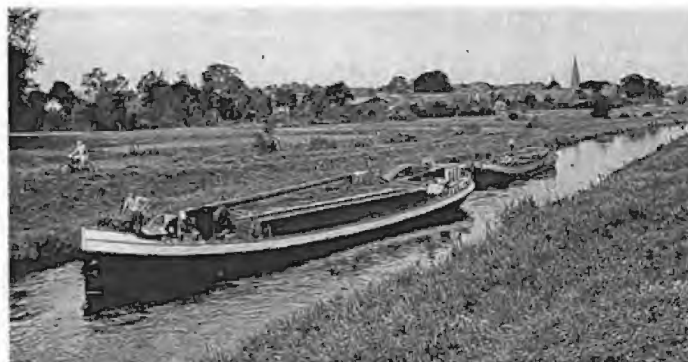
Blick von der Ankeloher Brücke auf Kanal (mit Frachtkähnen) und Flecken.
